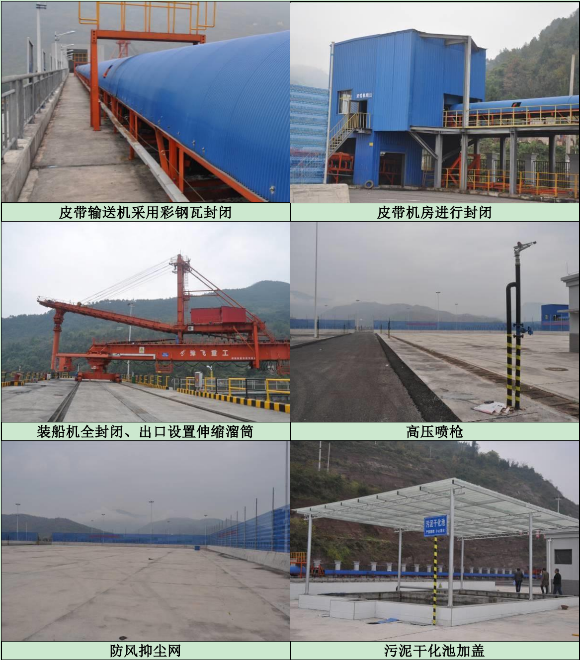
图 2.1-5 重庆港开州港区白家溪作业区一期大气污染防治措施照片
