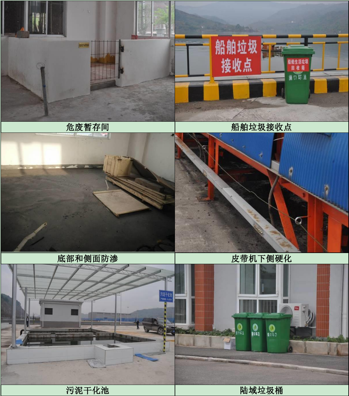
图 2.1-6 重庆港开州港区白家溪作业区一期固体废物污染防治措施照片
