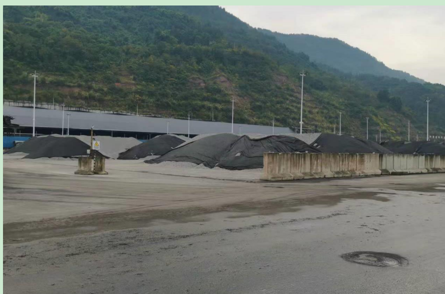
图 2.1-2 本次拟改建的 201-204#件杂堆场现状照片
