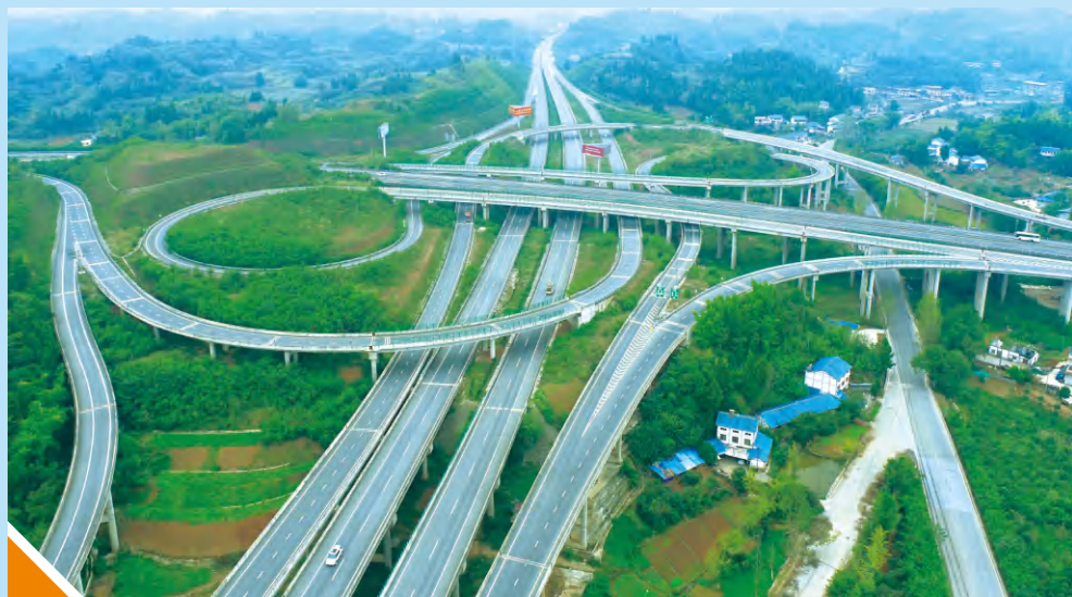
图2.6 已完成自主验收报备的重庆合川至四川安岳高速公路工程（重庆段）
