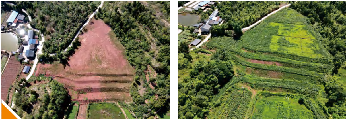
图2.3 重庆铜梁至四川安岳高速公路弃土场（左图为整改中，右图为整改后）
